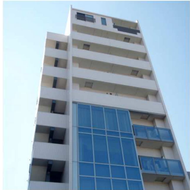
川崎市本社ビル
