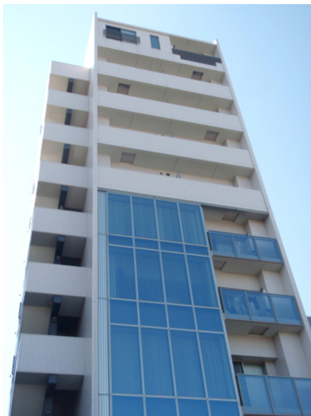
川崎市本社ビル
